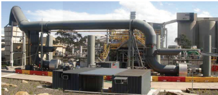
Слика 9. Метанска термоцентрала на руднику угља West Cliff (Аустралија)
